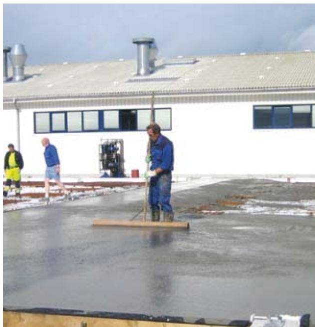
Afsluttende jutning inden betonoverfladen afdækkes med plastfolie.
