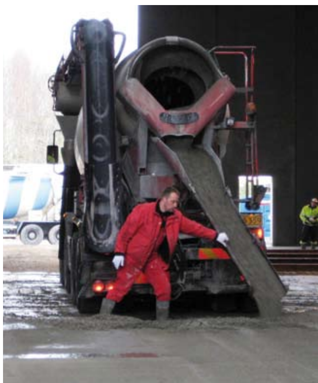
Betonkanon kører ind på underlag og læsser af.
