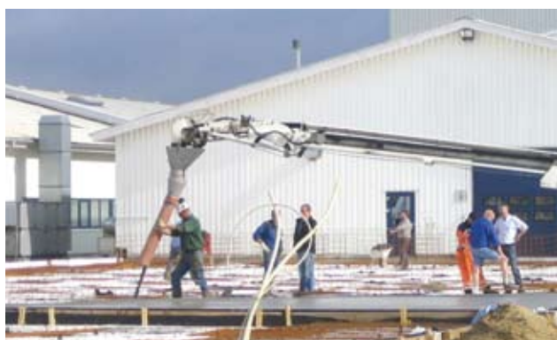
Udlægning af SCC-beton med bånd.
