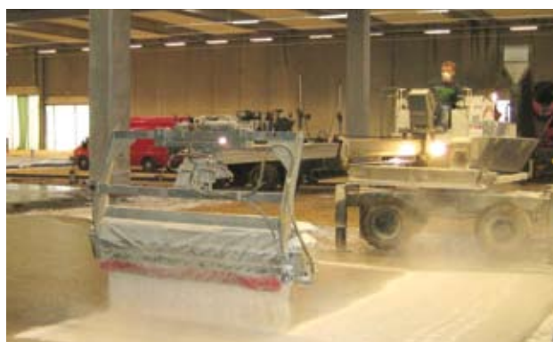
Hårdbeton i pulverform strøs ud umiddelbart efter at betonen er udlagt.
