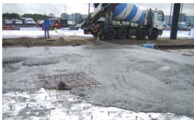
Over alle pæle udlægges lokalt netarmering.
