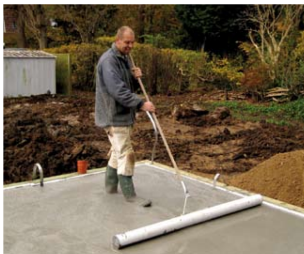
Udlægning og "jutting" af stålfiberbeton med selvkompakterende beton (SCC)
