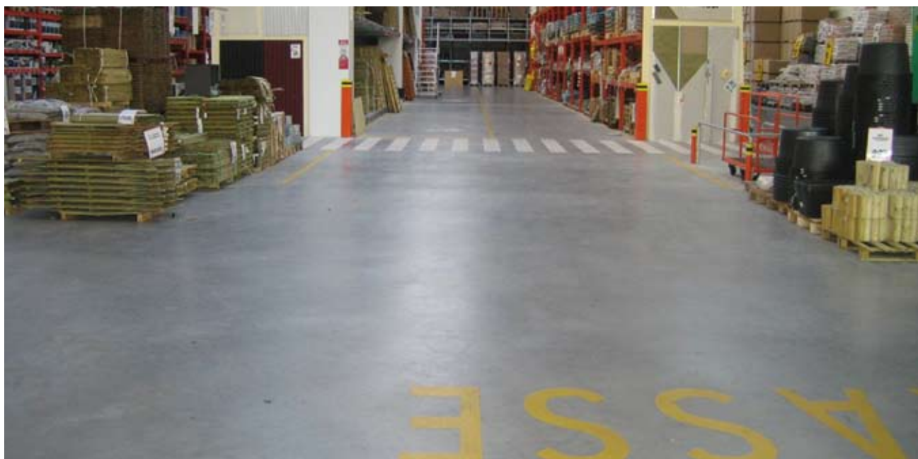
Det færdige resultat med fugefrie arealer på op til 40 x 40 m.
