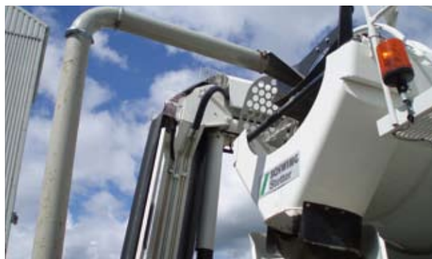
Stålfibre tilsættes den friske beton i rotérbil via en "dino".
