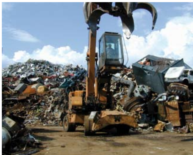
Belægning af stålfiberbeton på skrotplads i København
