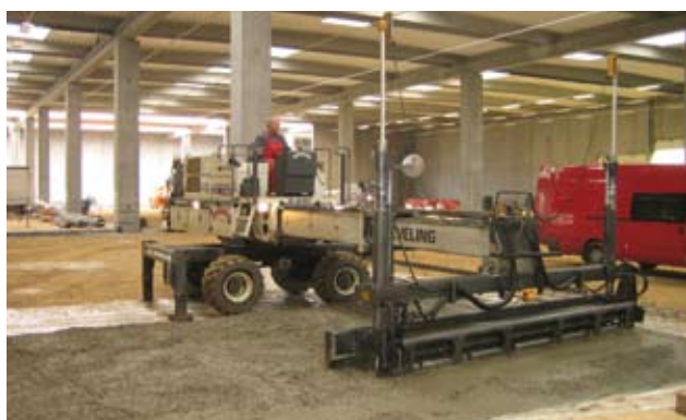
Udlægning med laserstyret udlæggermaskine (LaserScreed).
