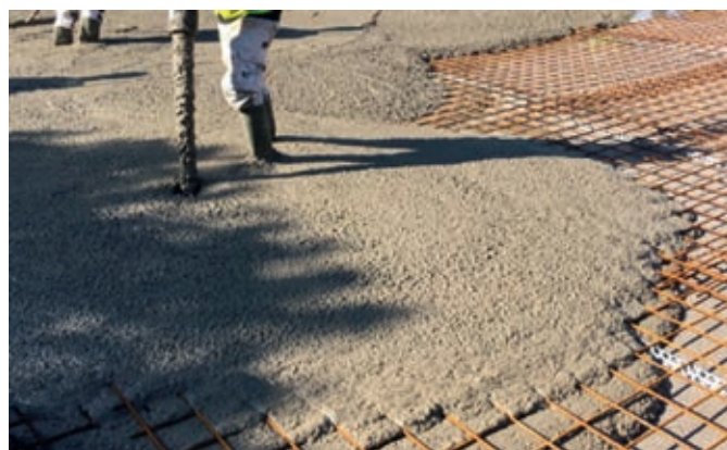
Foto 1. Pladsstøbning på Aalborg Portlands fabriksareal med beton med FutureCEM.
