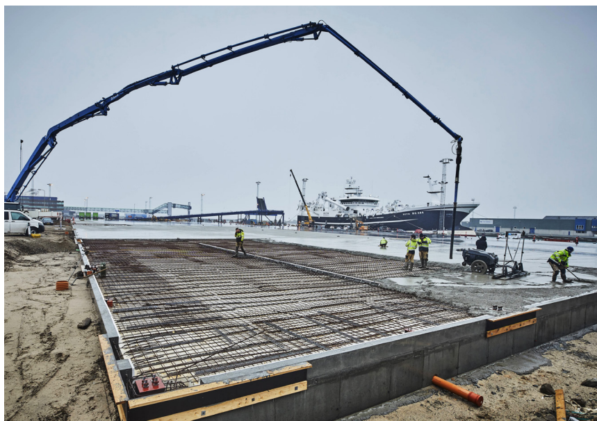
Støbningen af fundament med FUTURECEM.
